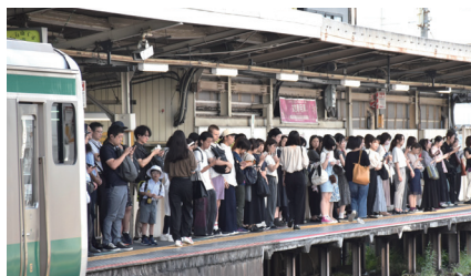
落下の危険と隣り合わせの十条駅ホーム
